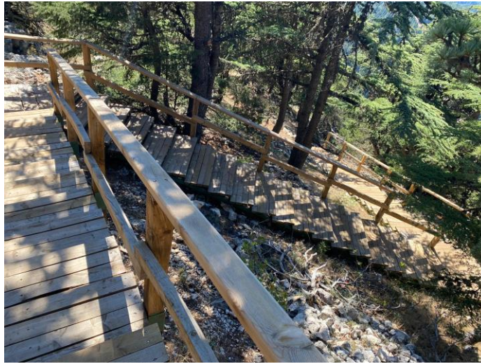
Şekil 3.7. Ekoturizm alanı ahşap merdiven kısmı (Foto: Leyla Bozkurt)
