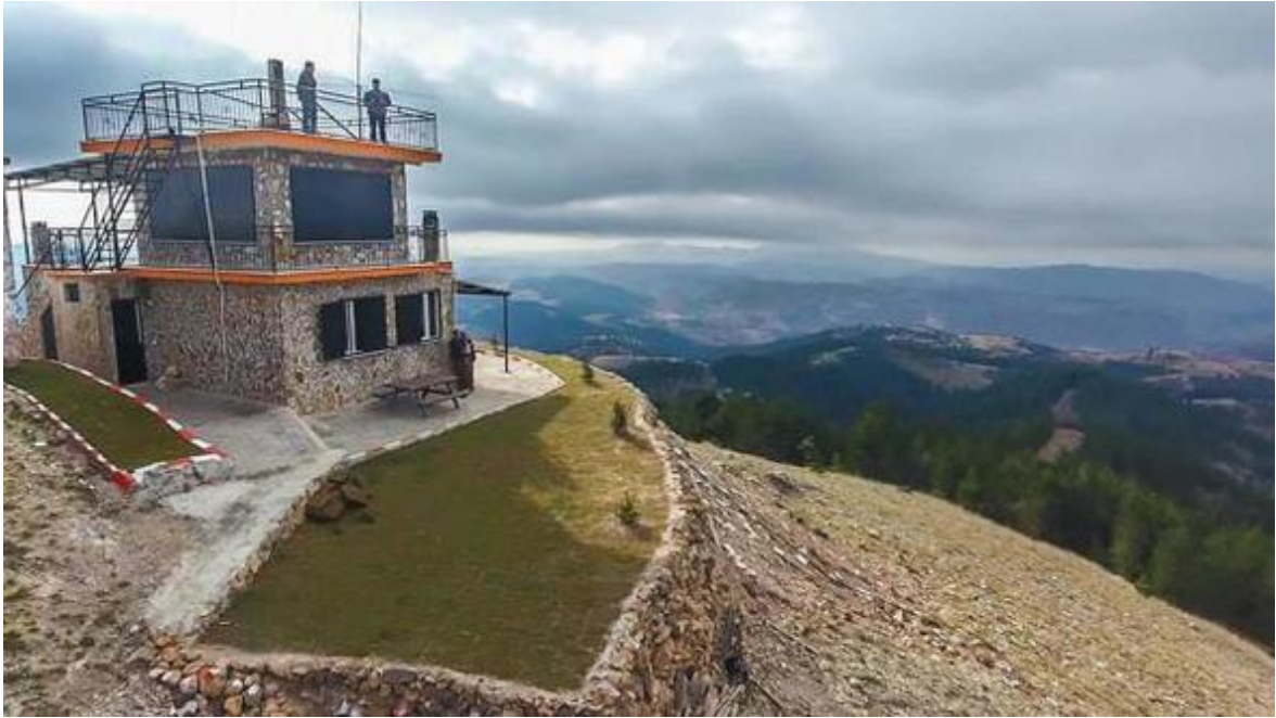
Şekil 1.6. Örnek bir yangın gözetleme kulesi
